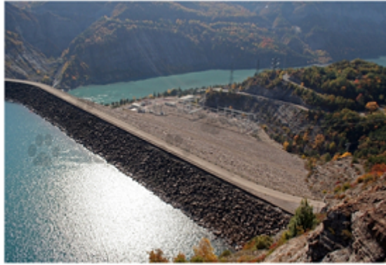
Barrage de Serre-Ponçon, Hautes-Alpes
