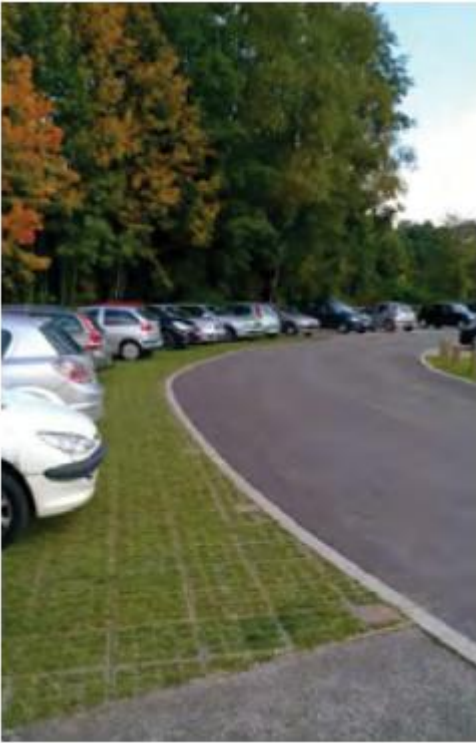
↓ Parking en dalles enherbées
