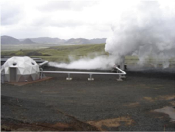
*Fig. 9 : Puits de production géothermique débitant un mélange eau-vapeur en Islande (photo J.Varet, 2006)*
