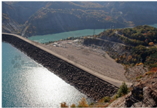
Barrage de Serre-Ponçon, Hautes-Alpes
