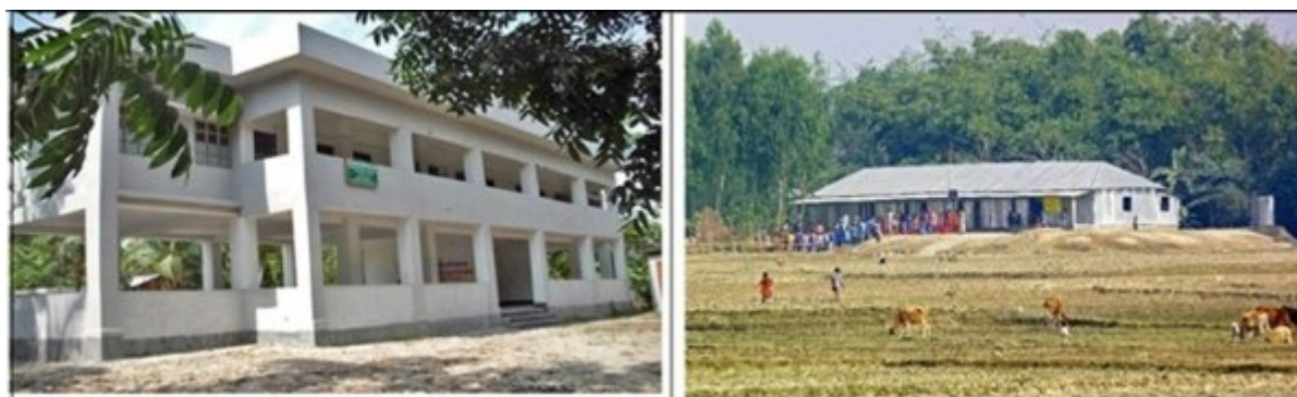
Photo 9 Abri anticyclonique [cf renvoi 11] - - Photo 10 Surélévation des installations d'Austochir [cf renvoi 11]
